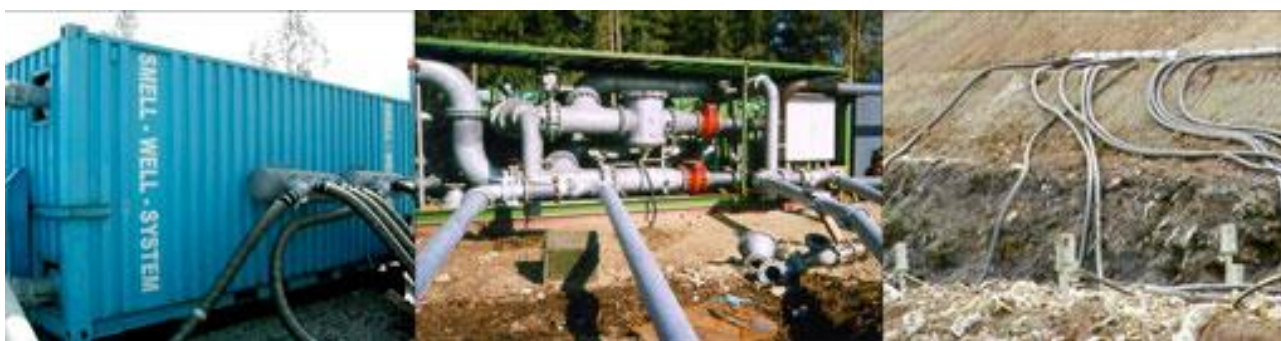
Slika ... - Izgled opreme u radu: Kontejner sa biofilterom (levo) - Priključak instalacije biofiltera (u sredini) - Cevni razvod na deponiji (desno)
